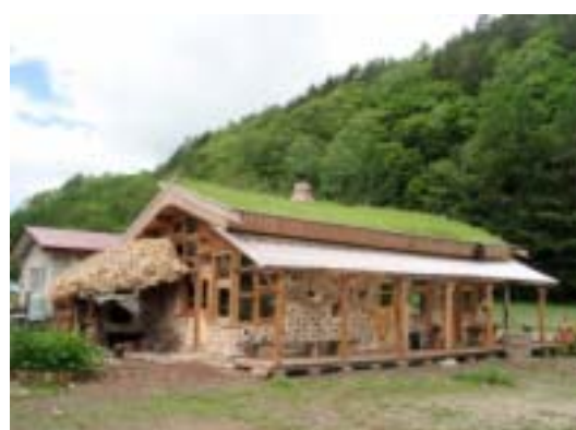
環境共生建築のコミュニティカフェ
