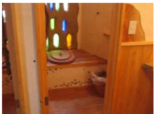
水も電気も使わない循環型の コンポストトイレ
