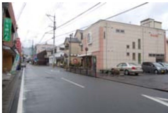
建物の連続性がない
