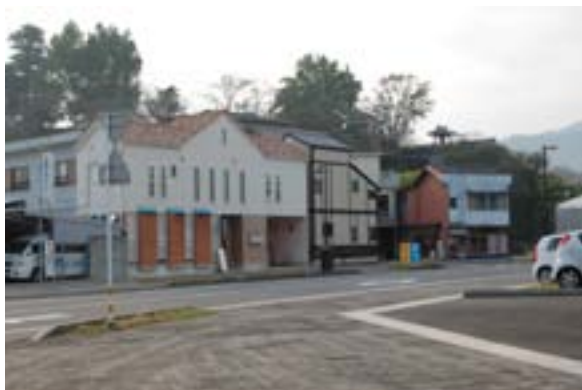
新設の白杵城跡下道路 辻入り口側
