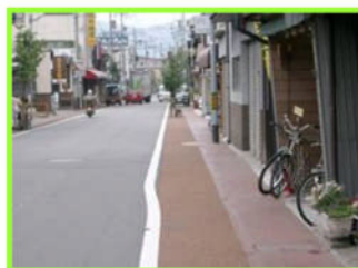
歩車道段差解消
