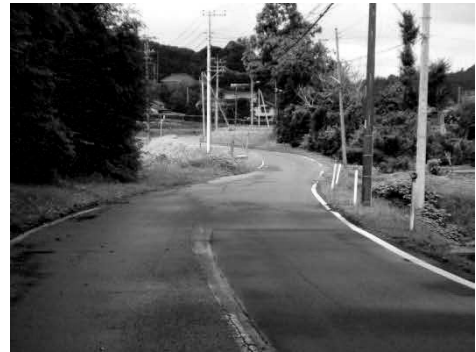
▲車両のすれ違い等に支障がある山間地の道路（上植野地区）
