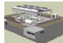
工場の低温廃熱を活用したバイナリー発電の整備
