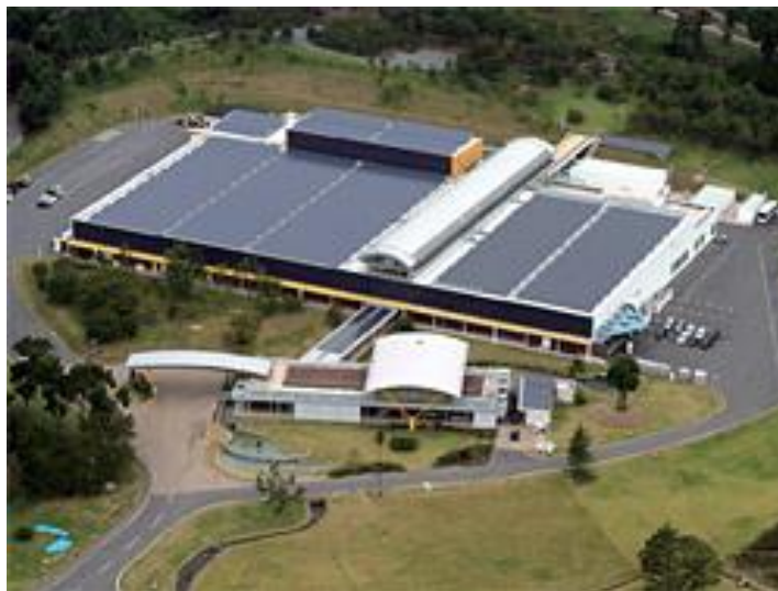
図表 2-2 再春館ヒルトップ菓彩工園（出力 820kW）
