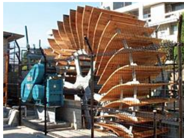
図表 2-9 家中川小水力市民発電所（最大出力 20kW）
