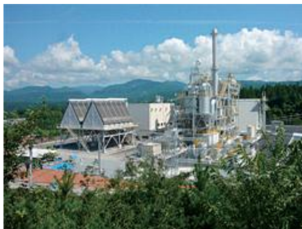
図表 2-15 日田ウッドパワー（出力 12,000kW）
