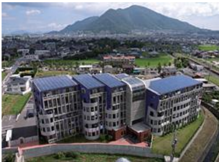
図表 2-3 太陽光発電システム付マンション（出力約 66kW：北九州市）
