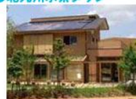
副生水素をバイプラインにより供給し燃料電池で利用
