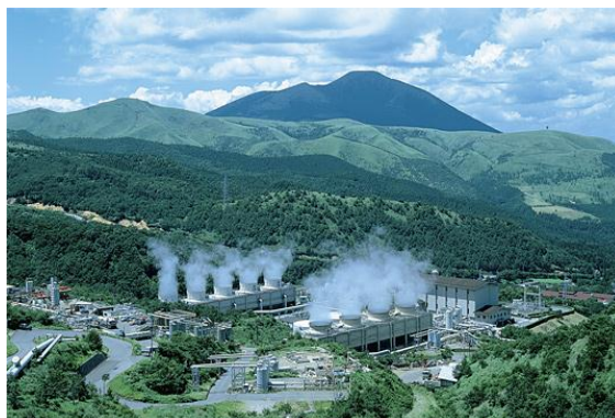
図表 2-11 阿蘇・八丁原地熱発電所（出力110,000kW）
