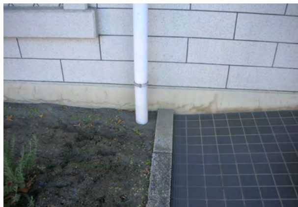
基礎：基礎立上がり
