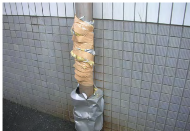
排水：雨樋が壊されている
