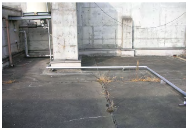
屋上：押えコンクリートの目地部に雑草が繁殖
