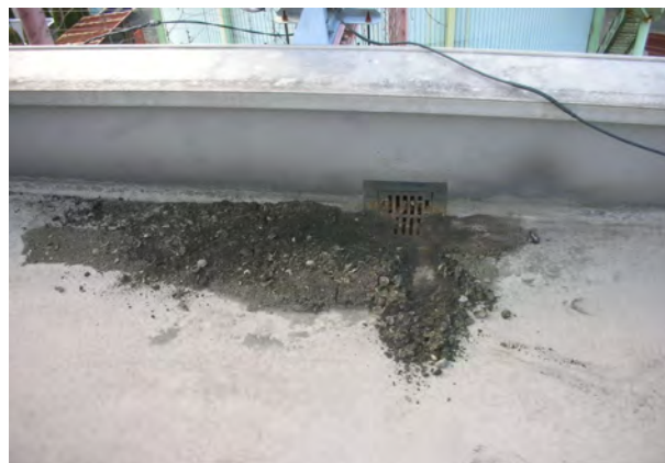
屋上：排水ドレーンに泥がたまる
