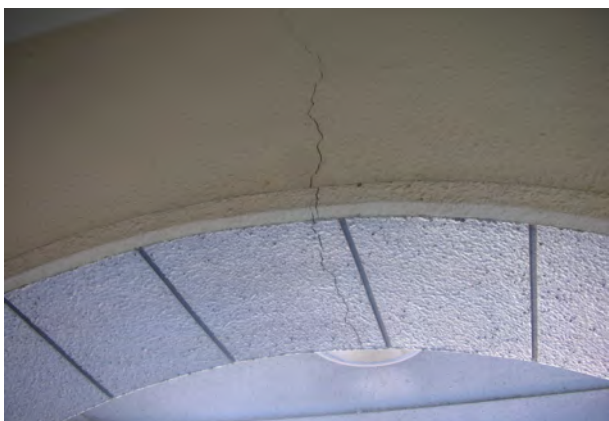
出入口：下がり壁にひび割れが発生
