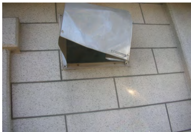
外部：換気扇が壊されている
