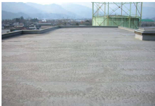
屋上：経過年数を考慮すると比較的傷みは少ない
