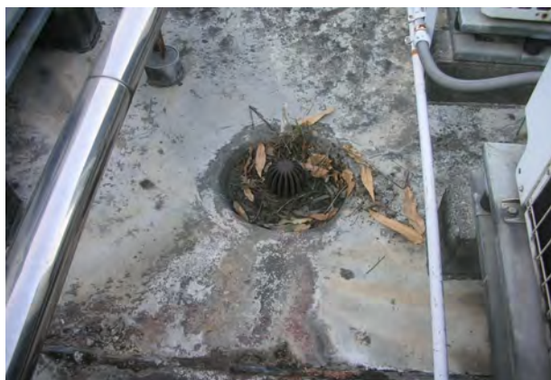
屋上：排水ドレーン
