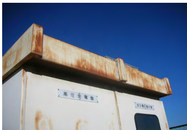
屋上：高圧受電室の外部パネルの腐食
