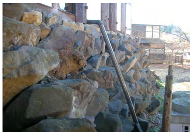
外部：基礎部周囲の石積
