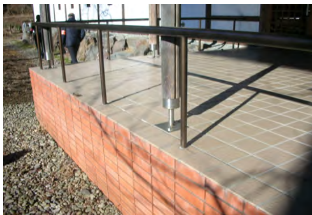
外部通路：外壁
