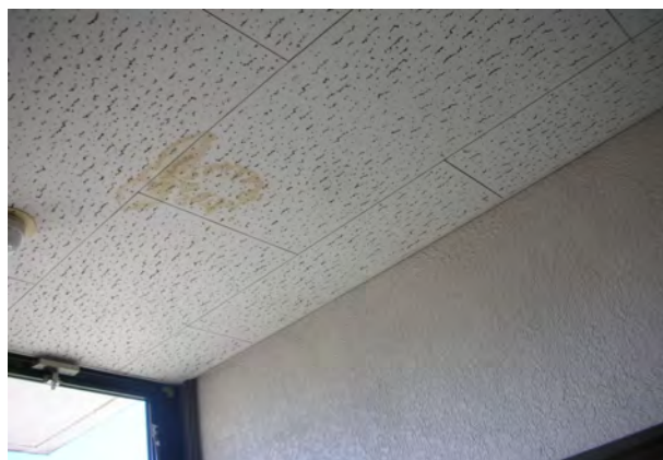
内部：天井の漏水跡
