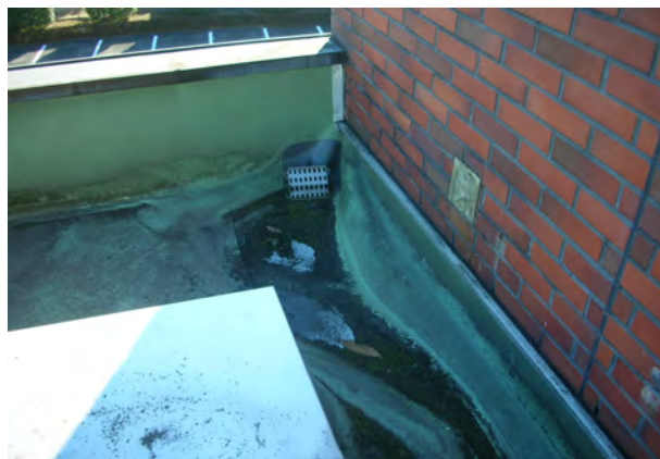
屋上：シート防水の劣化による膨らみ
