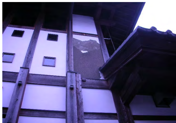
外壁：プラスター塗の剥落
