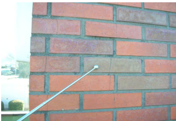
外壁：タイルにひび割れ
