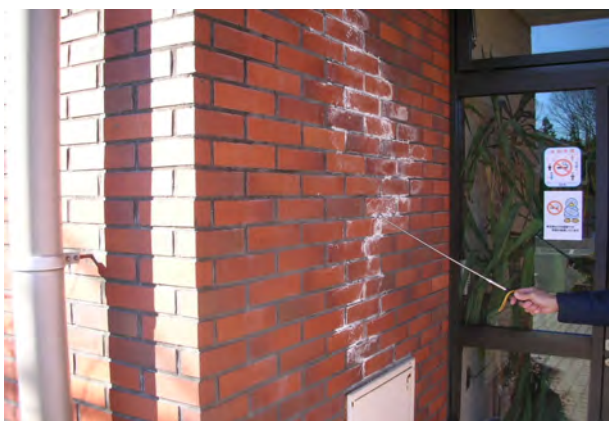
外壁：タイルの白華現象
