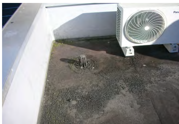
屋上：排水ドレーン周囲
