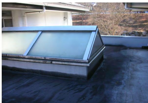
屋上：平場の防水とトップライト
