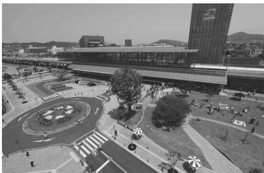
JR 連続立体交差事業により整備された日向市駅
