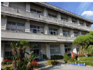
芝坂小学校の校舎全景
