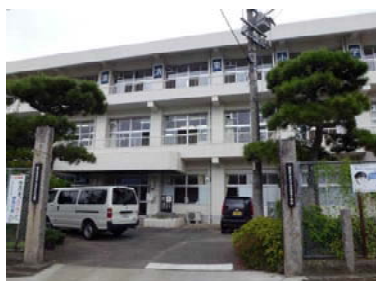
重清東小学校の校舎全景
