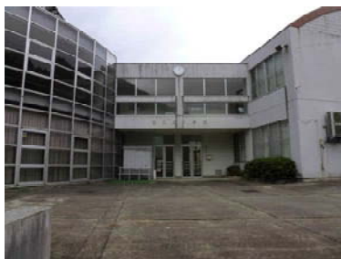
切久保小学校の校舎全景
