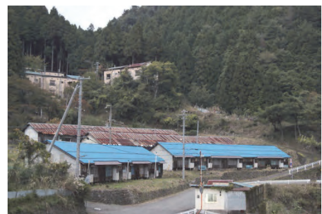
平成 25 年度に改修された旧北星社宅
