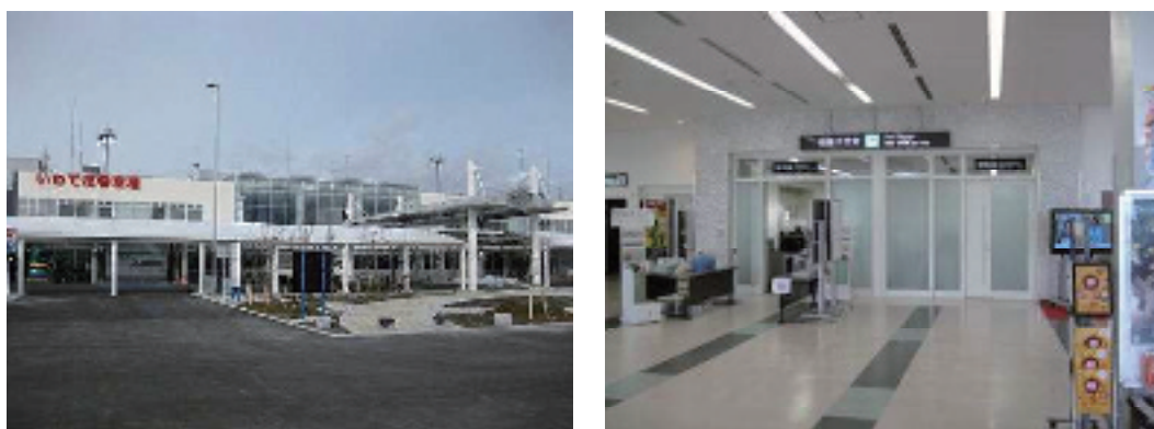
図31 いわて花巻空港の状況
