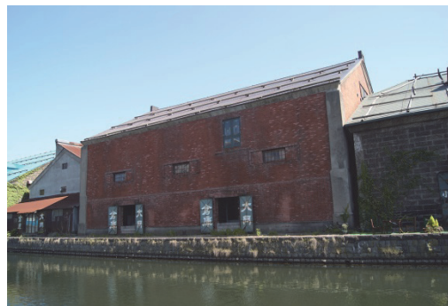
登録歴史的建造物の保全事業 運河沿いに建つ旧篠田倉庫（大正 14 年）
