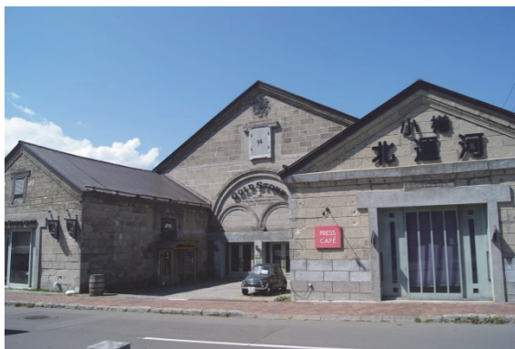
本事業により整備された旧渋澤倉庫（明治28年） レトロな外観を生かしたライブハウス、カフェとして営業中
