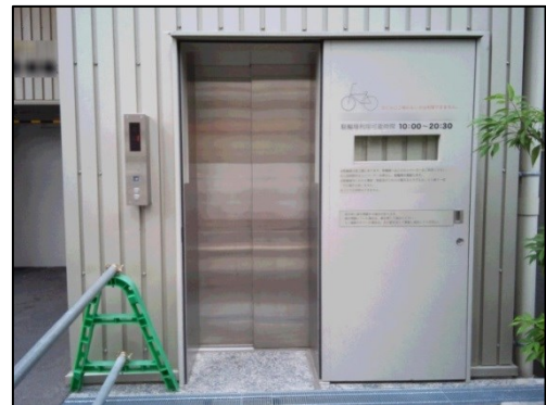
図表 2.60 屋上駐輪場用のエレベーター
