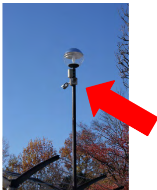
防犯・安全設備（防犯カメラ）
