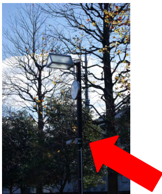
防犯・安全設備（防犯カメラ）
