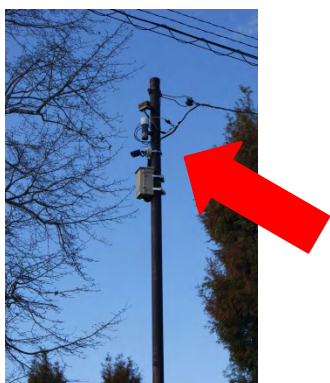
防犯・安全設備 (防犯カメラ)
