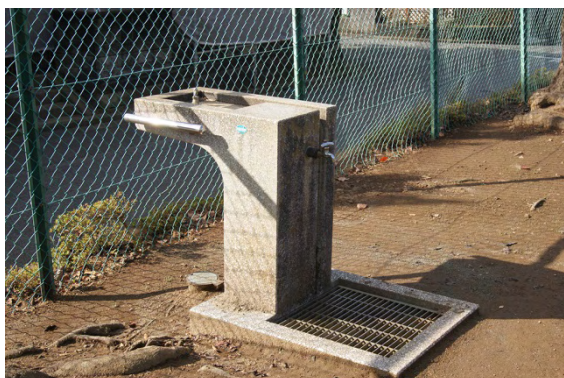
給水設備 (手洗い場・水飲み場)
