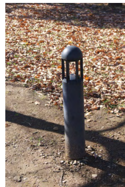
塗装・修復状況
