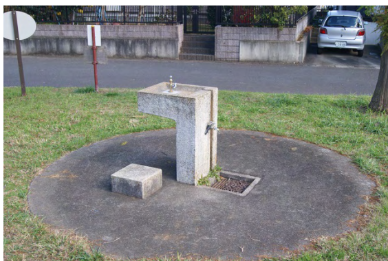
給水設備（手洗い場・水飲み場）
