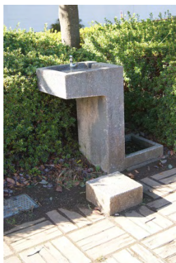
給水設備 (手洗い場・水飲み場)
