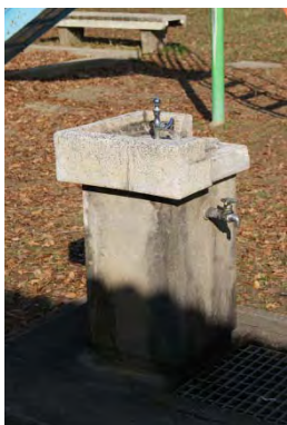
給水設備 (手洗い場・水飲み場)
