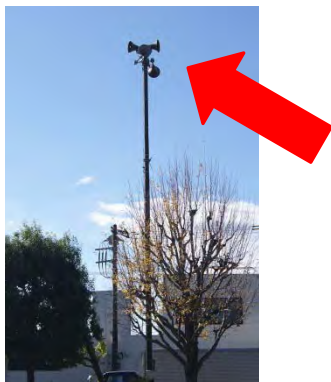
防犯・安全設備（防災無線）
