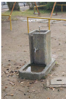
給水設備 (手洗い場・水飲み場)
