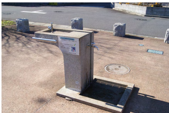
給水設備 (手洗い場・水飲み場)
