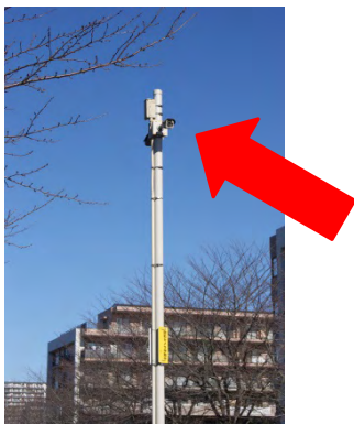
防犯・安全設備（防犯カメラ）
