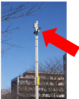
防犯・安全設備
