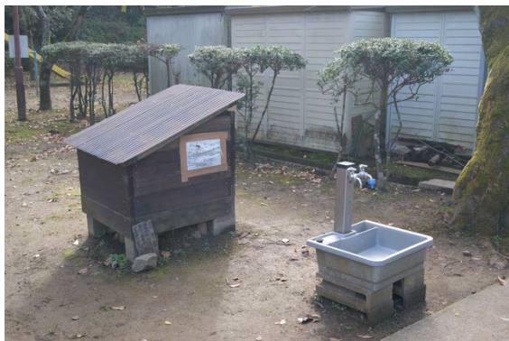
給水設備 (手洗い場・水飲み場)
