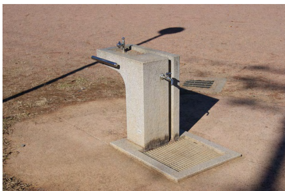
給水設備 (手洗い場・水飲み場)
