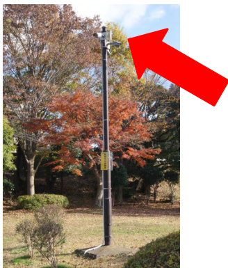
防犯・安全設備（防犯カメラ）
