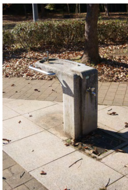
給水設備 (手洗い場・水飲み場)
