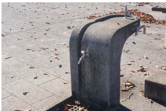
給水設備 (手洗い場・水飲み場)
