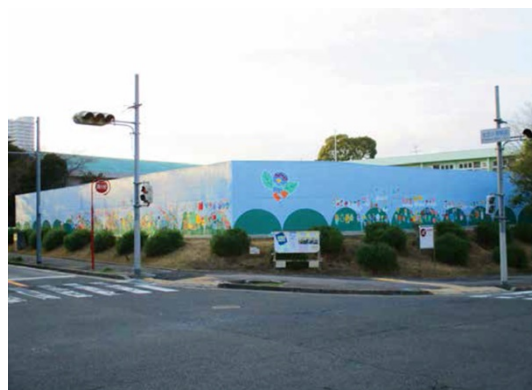
ペイントが完成した外壁
