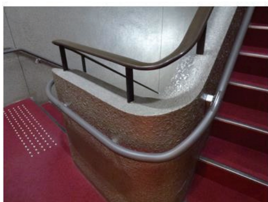
低い位置の階段手すり新設
