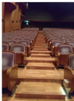
小階段の奥行を広げるために踏面を大きくした(通行時の安全確保)
