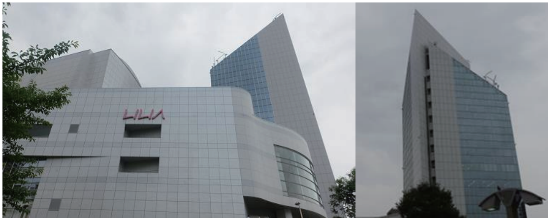
図表(写真)2-1-1 川口総合文化センター外観
