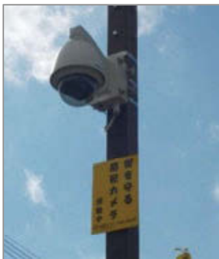
◀ 防犯カメラ設置の様子
