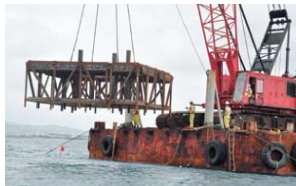
海洋に設置された魚礁=当添漁港地先
