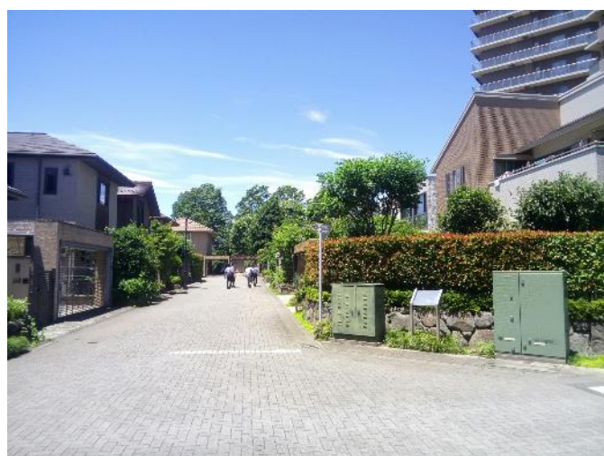
図 4-35 民間宅地開発における無電柱化の事例
