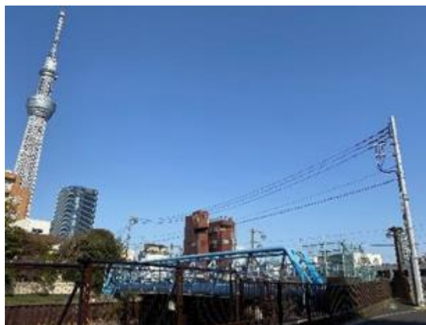
図 5-12 橋りょう部架線状況
