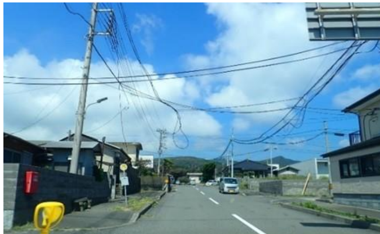
図 4-14 大島クダッチ地区の被害状況（令和元年9月）
