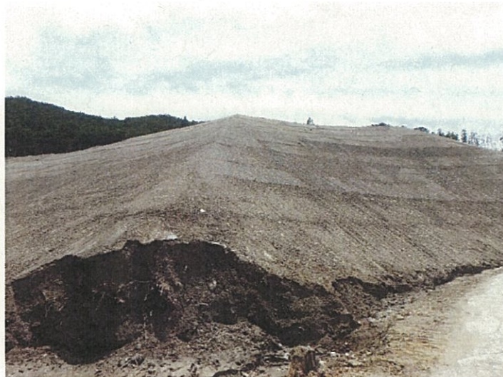
堆積状況（紀北町）
