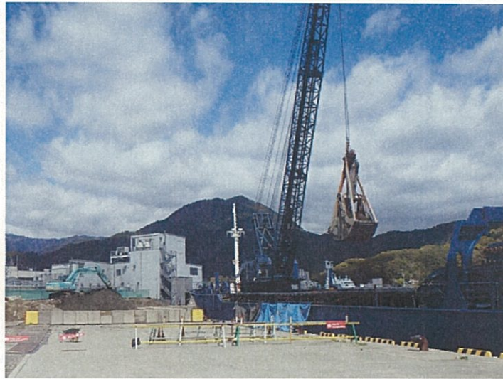
港湾受入の状況（尾鷲市）
