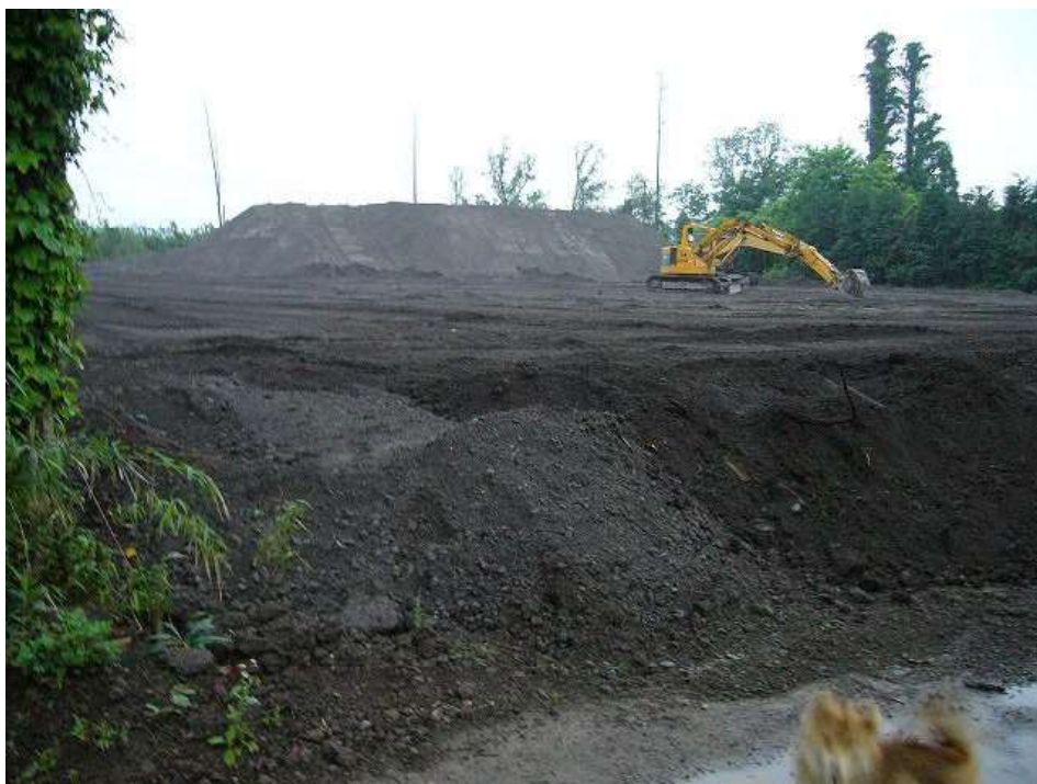
図8 大規模な残土処分場（その2）
