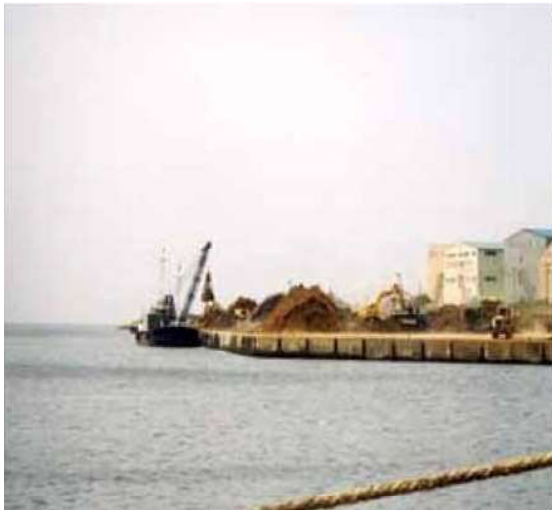
図4 船で運ばれ 陸揚げされる残土
