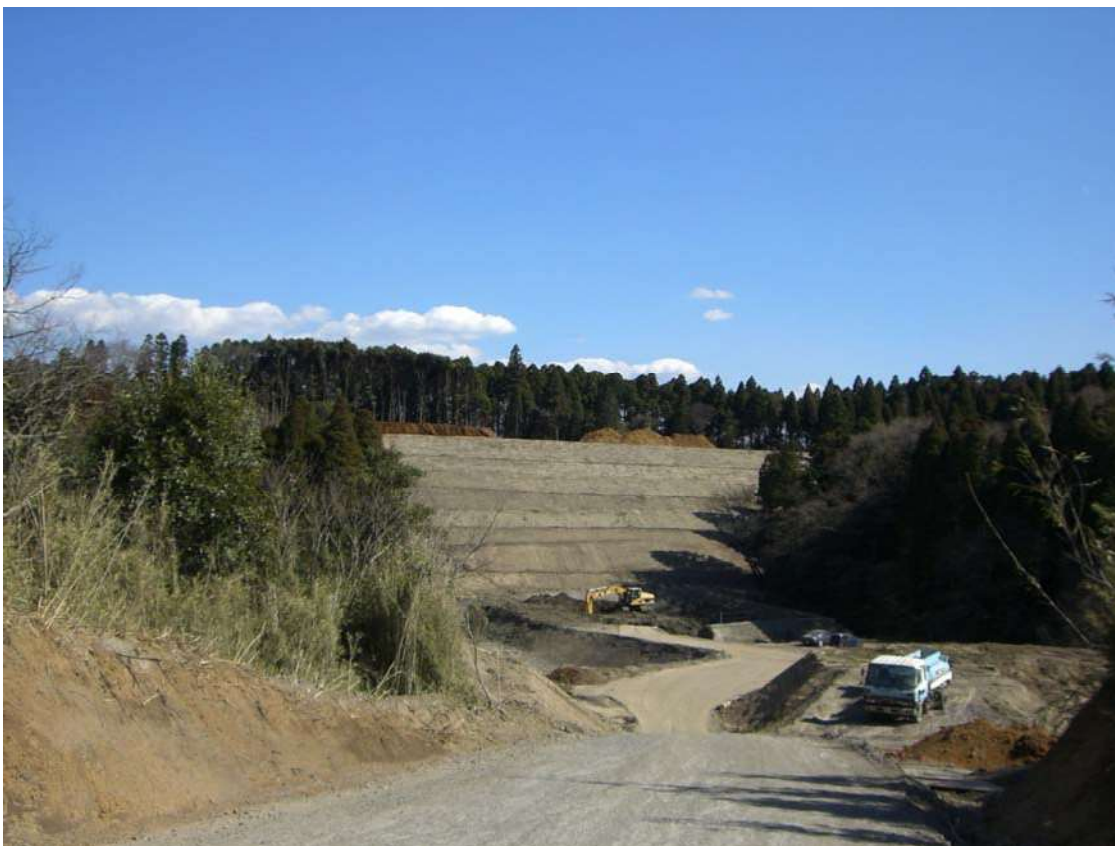
図10 法面として利用されている残土
