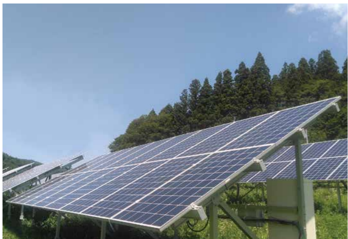
耕作放棄地を活用した太陽光発電（筆甫地区）
