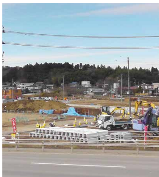
地盤強化で安心な住宅完成を (町営神明・災害公営住宅建設現場)
