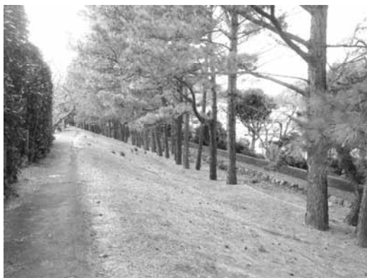
写真2-7 江戸期に日常利用と防災機能を両立させた広村堤防 (和歌山県広川町)
