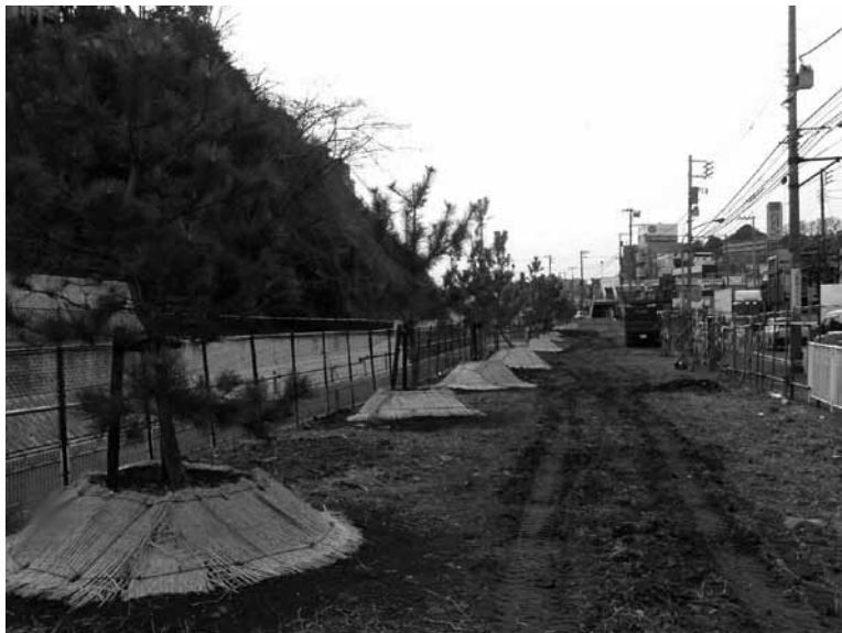
写真1-4 旧街道の松並木と歩道の工事中
