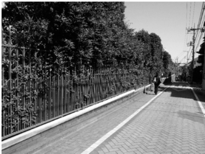
写真2-4 閉鎖的にならないように工夫された学校の塀
