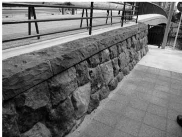
写真2-5 現地にあった石積みを再利用した西仲橋の橋詰 (東京都中央区)
