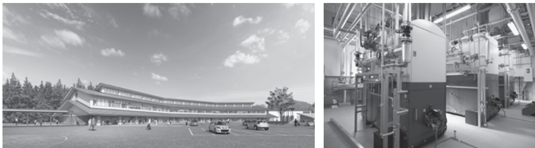
図2 国民健康保険沢内病院完成図と設置予定のチップボイラー
