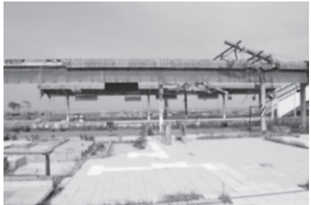
津波の被害を受けたJR富岡駅
