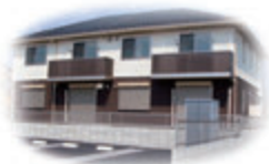
平成23年完成：若者住宅（集合住宅4戸）
