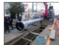
(耐震管の敷設工事)
