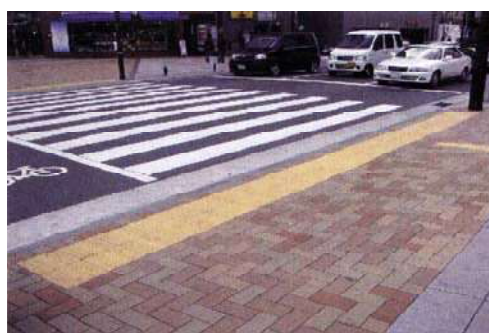
歩道の段差・勾配の改善、視覚障害者用ブロック等の設置
