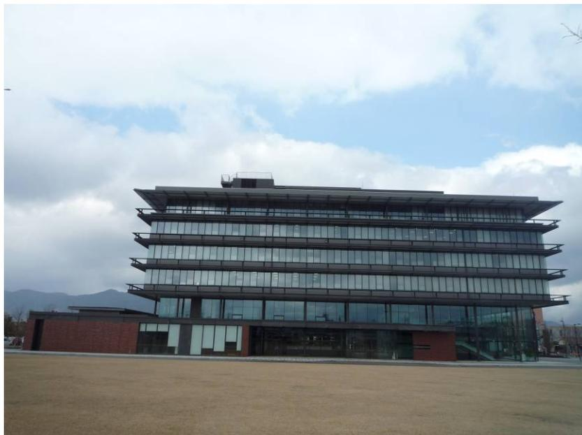
各階の四方に設けた水平ひさしは。グレーチングを採用し、直射日光を遮ぎり、明るさを確保すると共に、メンテナンス用通路として利用できる
