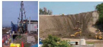
詳細調査 (ボーリング)
