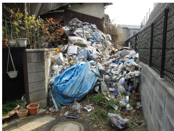
仮囲い設置前
