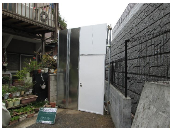
仮囲い設置後
