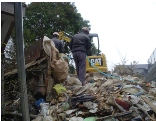
小型重機による解体
