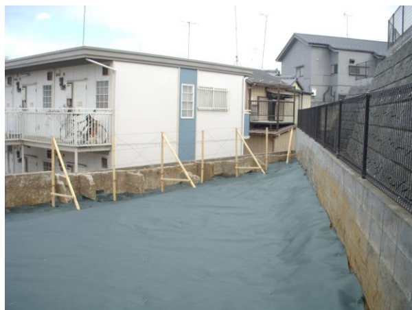
防草シート+木杭設置状況
