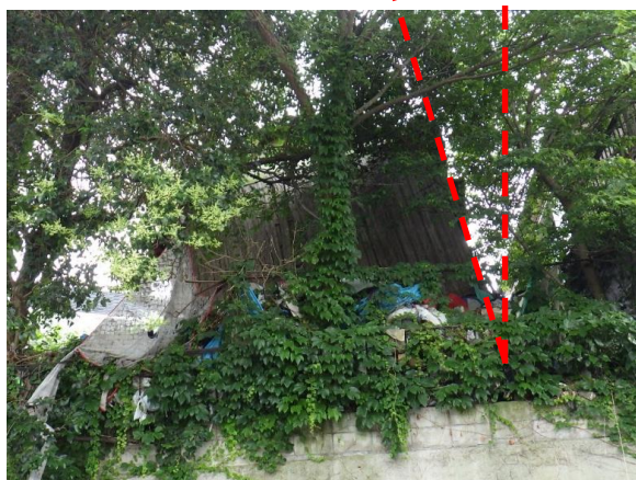
敷地北側から
